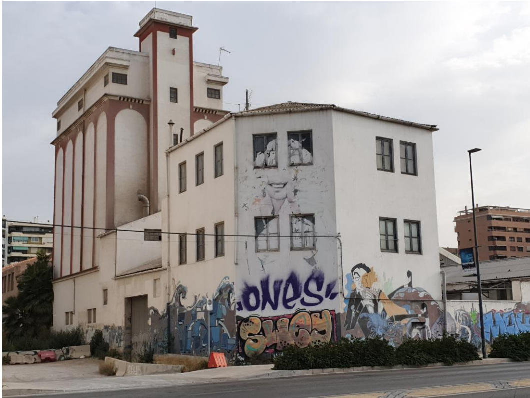
Fotografía 1. Fachada avda. Elche Museo Etnológico Alicante en Harineras Benalúa
